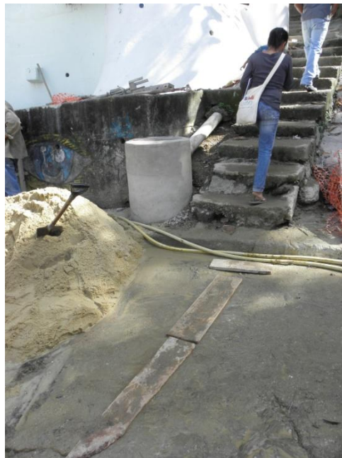
Figura 30 – caminho improvisado para pedestres durante as obras.
