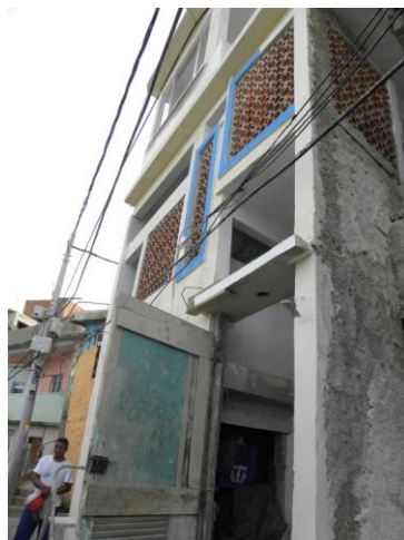
Figura 44 - Casa incluída nas ações de melhorias habitacionais.
