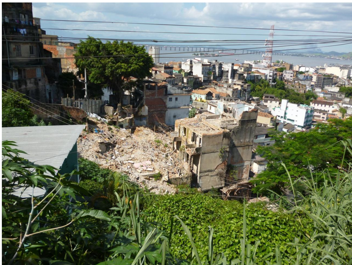
Fotografia 19: Apê prédio demolido onde antes havia uma vila que fazia parte da mesma propriedade (fev. 2012)
