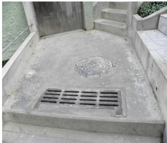
Figura 47 – Obras de pavimentação e infraestrutura.
