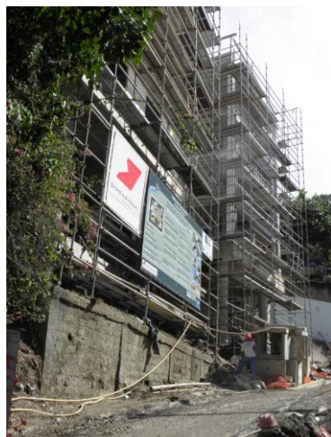
Figura 43 – Construção de Conjunto habitacional na Ary Barroso.
