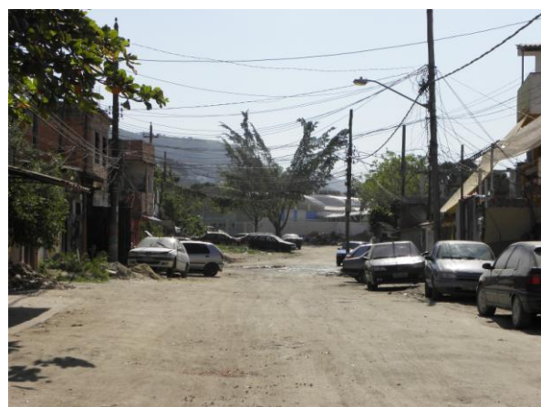
Figura 13 – Rua em Área Verde, local onde há incidência de alagamentos.
