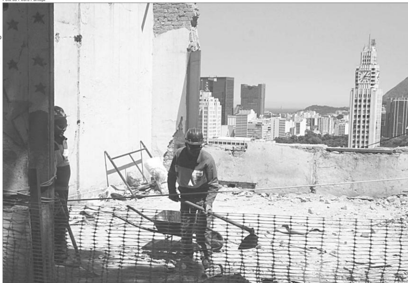
Obras do “Morar Carioca” no Morro da Providência têm levantado polêmicas pois falta fiscalização no Programa de “Compra Assistida” aos desalojados
