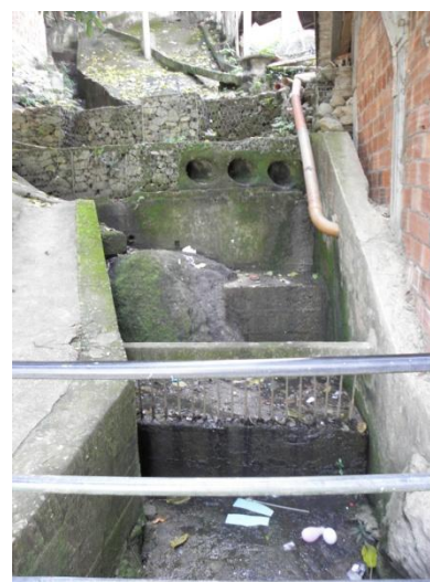
Figura 34 – Saída de águas servidas – Chapéu Mangueira.
