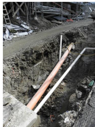
Figura 45 – Obra de infraestrutura – Babilônia.
